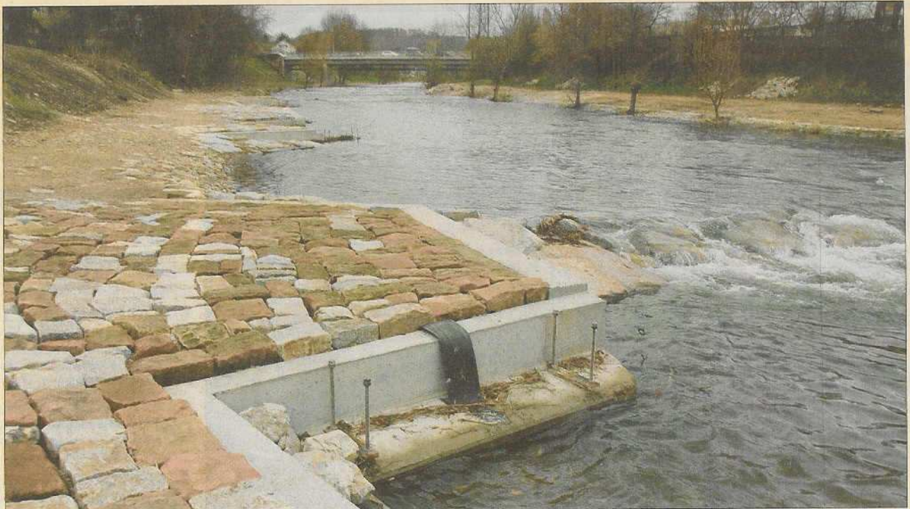
An der Wiese wurden unterhalb der Tumringer Brücke Buhnen errichtet.
